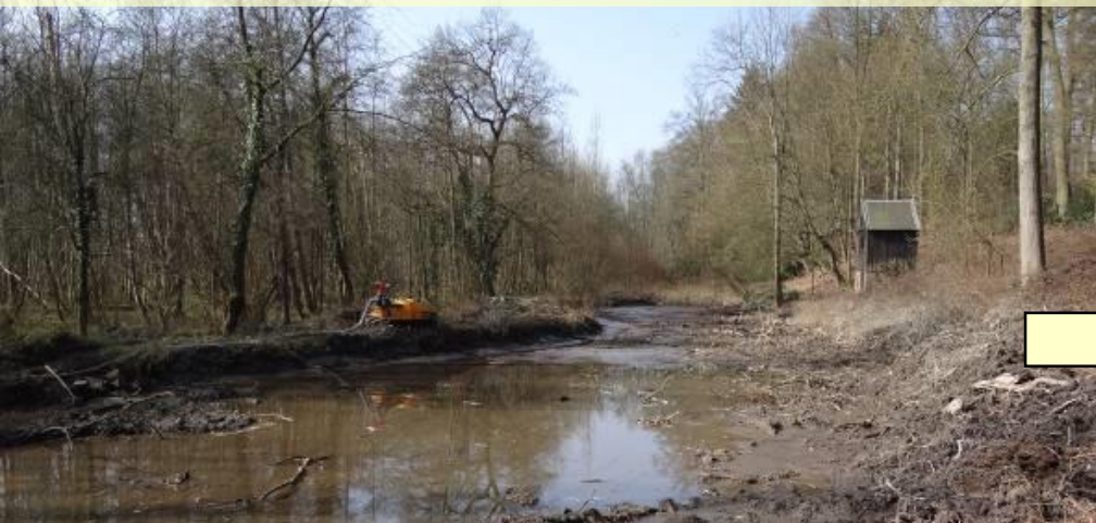
Restauration d'un étang
